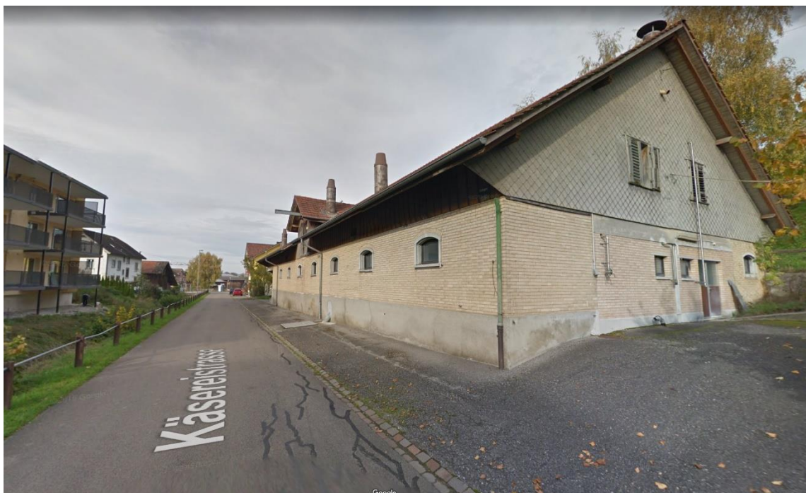
Fig. 1: l'ancien bâtiment agricole à Tobel-Tägerschen (à droite sur la photo) a été remplacé par un immeuble locatif (cf. photo dans énoncé de l'exercice) en 2015, ce qui a entraîné une augmentation de valeur (photo Google StreetView , 2013).
