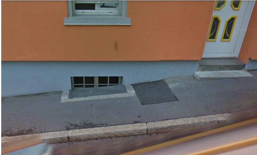
Abb. 3: Gebäude in der roten Gefahrenzone im oberen Stadtbereich an der Rue des Anciens Moulins 14. Screenshot aus Google Earth.
